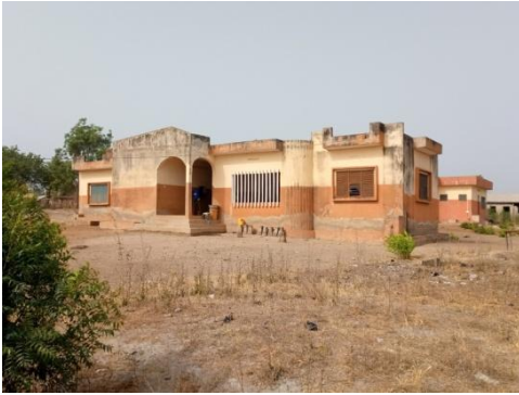
Vorhandene Krankenstation in Kikélé
